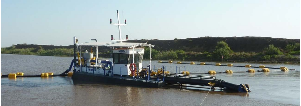
Figur 3-9: Cuttersuger monteret på flåde med pumpestation og jordspyd for fastholdelse under arbejdet
