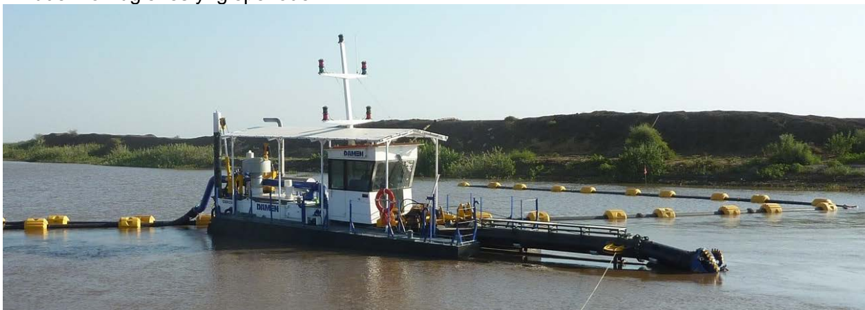
Figur 2-9: Cuttersuger monteret på flåde med pumpestation og jordspyd for fastholdelse under arbejdet
