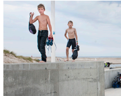
Eksempel på kanter i beton Foto: Normann Sloth
